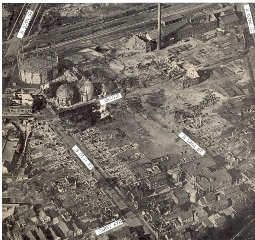
Рис. 2. Снимок последствий аварии на заводе СПГ в Кливленде
